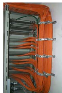
Netzschränke, Kabelführungen
